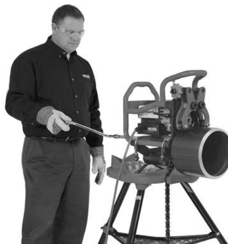
Rys. 20C – Czynnosc ukosowania (nieruchoma ukosowarka/obracajaca sie rura)
