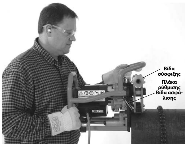
Εικόνα 15Α – Τοποθέτηση του εργαλείου φρεζαρίσματος πάνω σε σωλήνα
