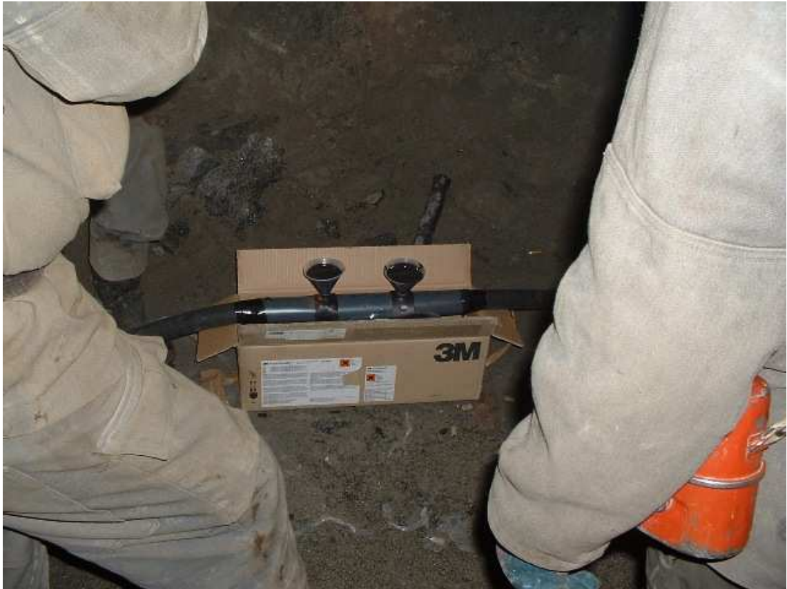
Рис. 24. Соединительная муфта модели 92-AV 524 PL на основе заливной технологии с полиуретановым гибким компаундом, смонтированная на кабеле типа КГЭ
