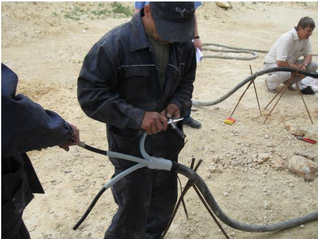
Рис. 29. Монтаж концевой муфты 92-ЕВ CS-1 на кабеле типа КГЭ техниками предприятия «ЕлецИзвесть»
