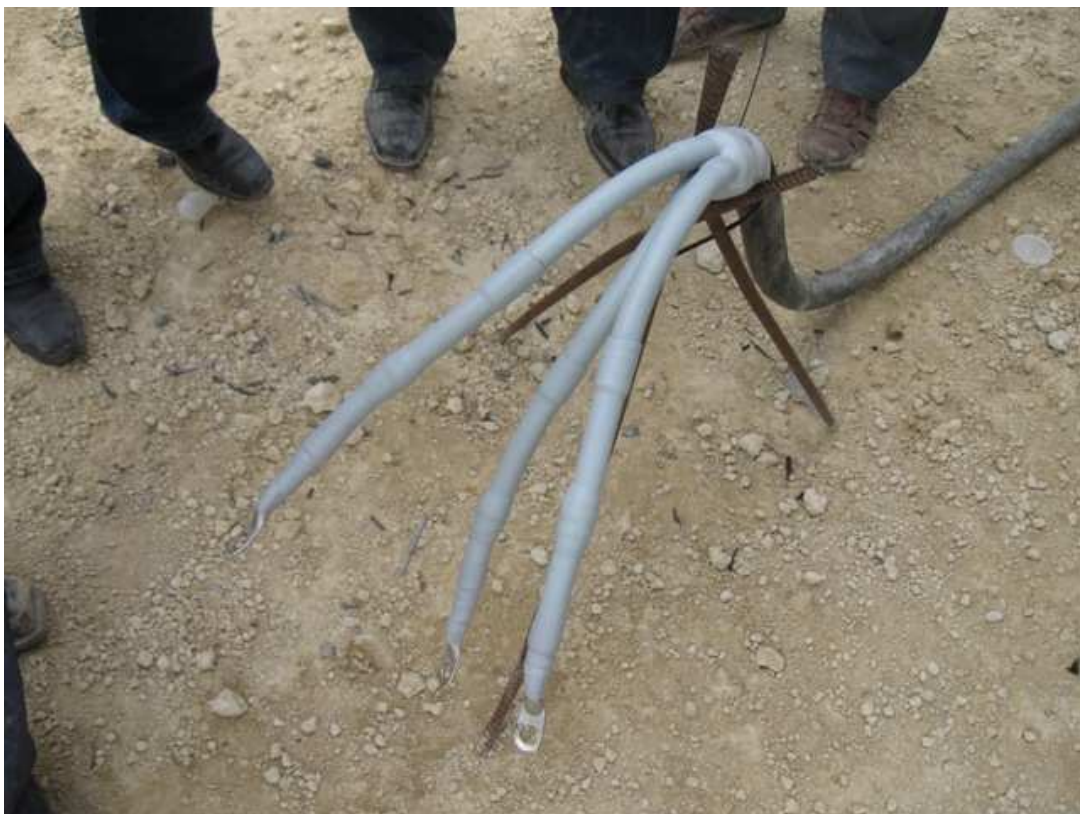
Рис. 30. Монтаж концевой муфты 92-ЕВ CS-1 завершен
