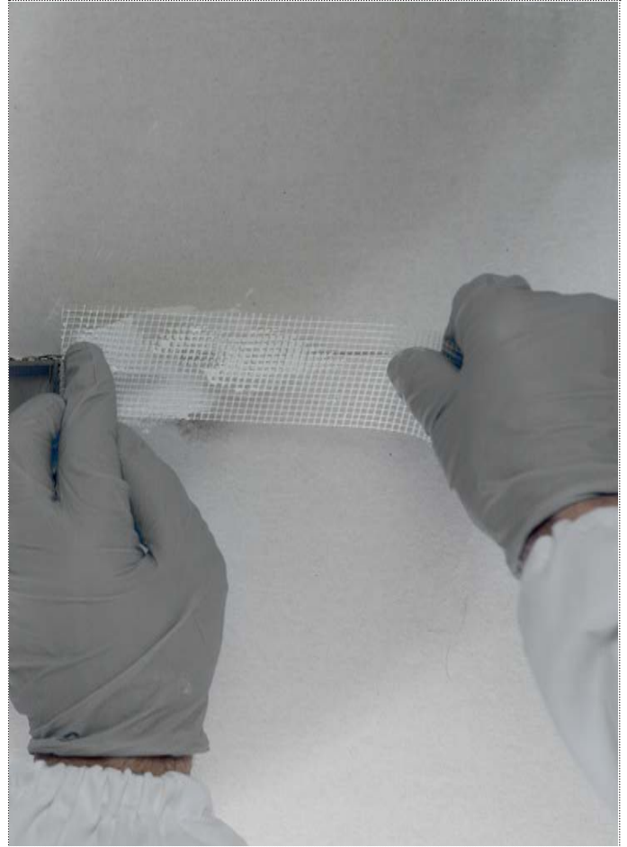
2_IT_Garzatura_EN_Mesh for plaster_FR_Gaze pour plâtre_ES_Gasa_DE_Armierungsgewebe_RU_Наклеиваем стыковочную ленту
