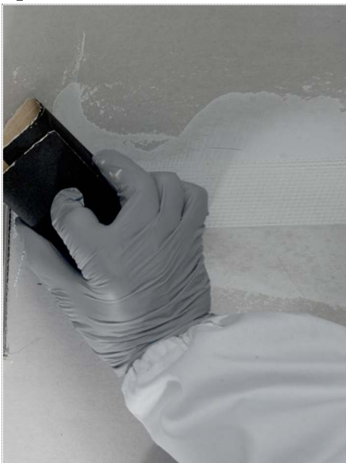
3_IT_Stuccatura_EN_GROUTING_FR_jointoiement_ES_Estucar_DE_Spachtelung_RU_Наносим шпаклевк
