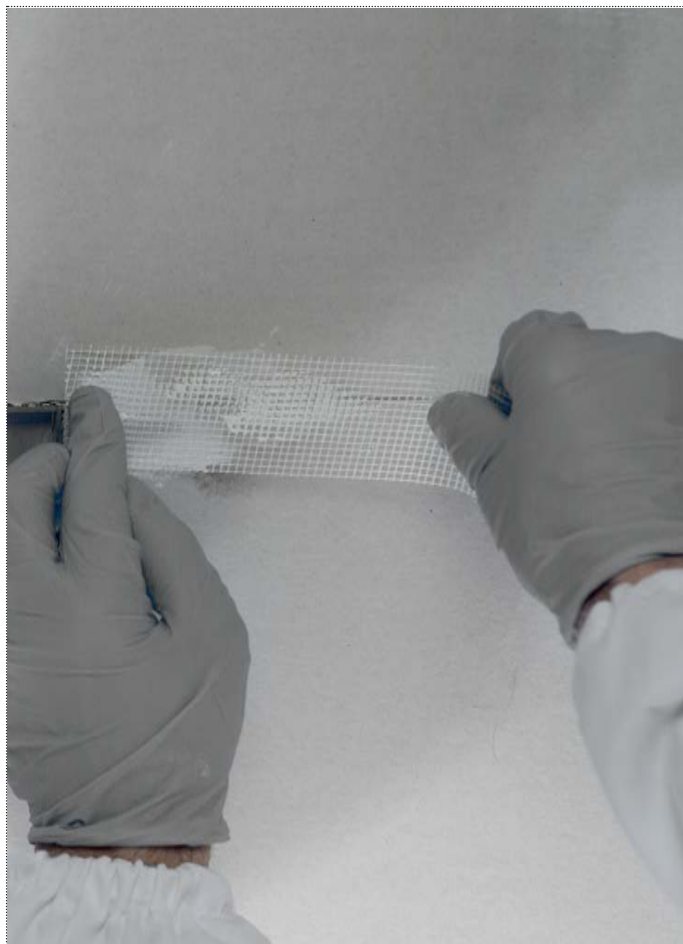
2_IT_Garzatura_EN_Mesh for plaster_FR_Gaze pour plâtre_ES_Gasa_DE_Armierungsgewebe_RU_Наклеиваем стыковочную ленту
