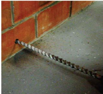
Пробиваются или высверливаются отверстия для прохождения трубы через стены и перегородки
