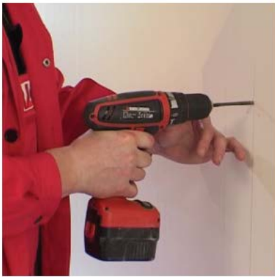
Высверливаются гнезда для крепления опор и водорозеток
