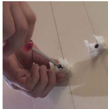
Устанавливаются подвижные опоры
