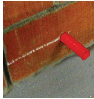
Устанавливаются гильзы из гофрированной трубы в отверстия стен и перегородок так, чтобы гильза выступала не менее чем на 50 мм за грань конструкции .
