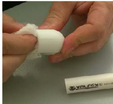
В случае, если концы труб и раструб фитинга сильно загрязнены, необходимо перед сваркой протереть их ветошью и обезжирить .
