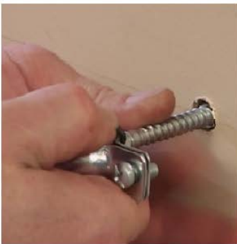
Устанавливаются неподвижные опоры
