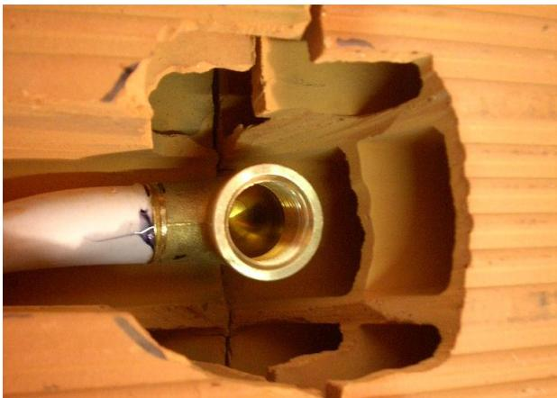
Preparare l'attacco da 1/2" per il montaggio del soffione.
