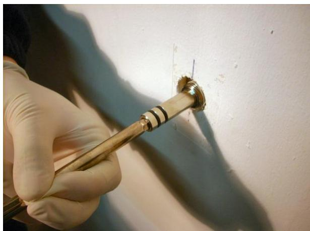
Avvitare il raccordo da 1/2" sull'attacco con chiave a brugola da 6 mm, utilizzando canapa o similari per realizzare la tenuta idraulica.
