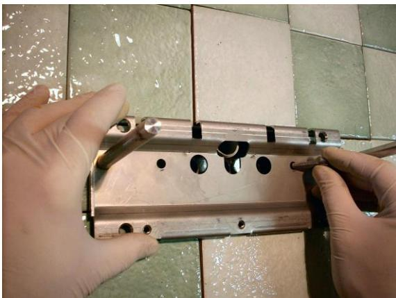
Fissare la piastra di sostegno al gruppo incasso serrando le viti con chiave a brugola da 5 mm.
