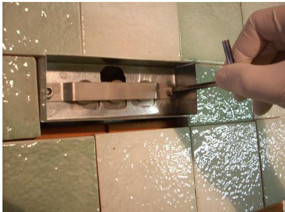
Rimuovere la piastrina di fissaggio svitando le due viti con chiave a brugola da 5 mm.
