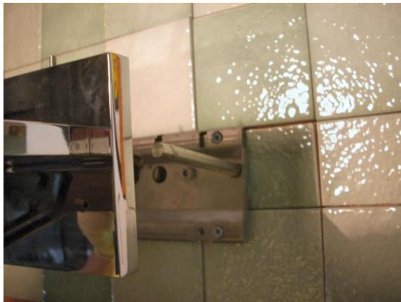
Montare il soffione sulla piastra di supporto inserendo le spine negli appositi fori.
