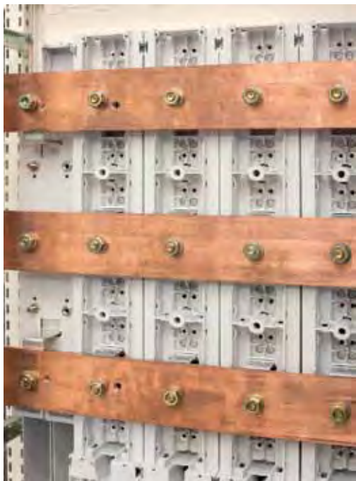
ISFL160 (прямое присоединение к распределительным шинам)
