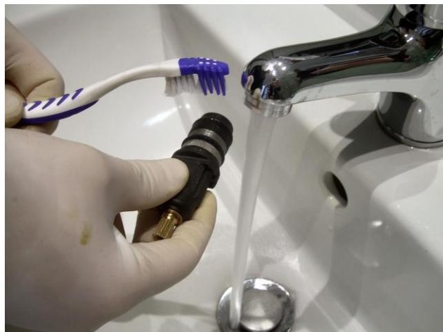
Nel caso fosse necessario pulire i filtri a rete utilizzare uno spazzolino e risciacquare in acqua corrente; nel caso di incrostazioni di calcare immergere per 8-10 ore la cartuccia in una soluzione di acqua e aceto (50%) e poi risciacquare in acqua corrente.
