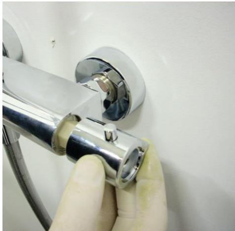
Inserire la manopola con il pulsante rivolto in alto e con l'indicatore della temperatura allineato alla tacca presente sul miscelatore SENZA ruotare l'asta della cartuccia.
