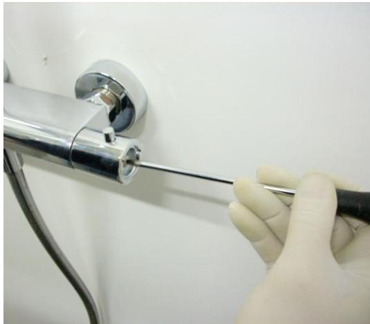
Bloccare la manopola di regolazione della temperatura avvitando la vite con cacciavite a stella.
