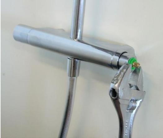
Inserire la cartuccia nel corpo del miscelatore e serrare la calotta con chiave inglese da 27 mm.
