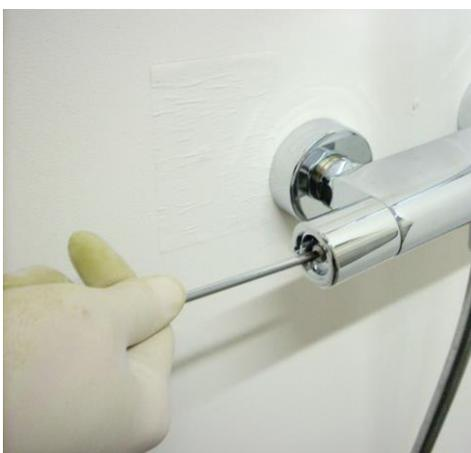
Rimuovere la manopola di apertura dell'acqua svitando la vite con cacciavite a stella.
