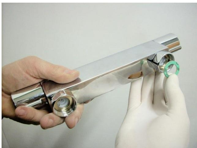
Inserire le guarnizioni di tenuta nelle calotte di serraggio.
