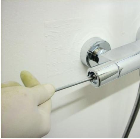
Bloccare la manopola di apertura dell'acqua avvitando la vite con cacciavite a stella.
