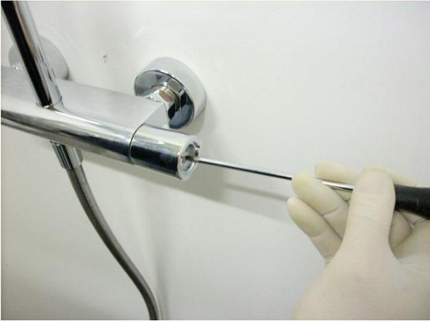
Bloccare la manopola di regolazione della temperatura avvitando la vite con cacciavite a stella.
