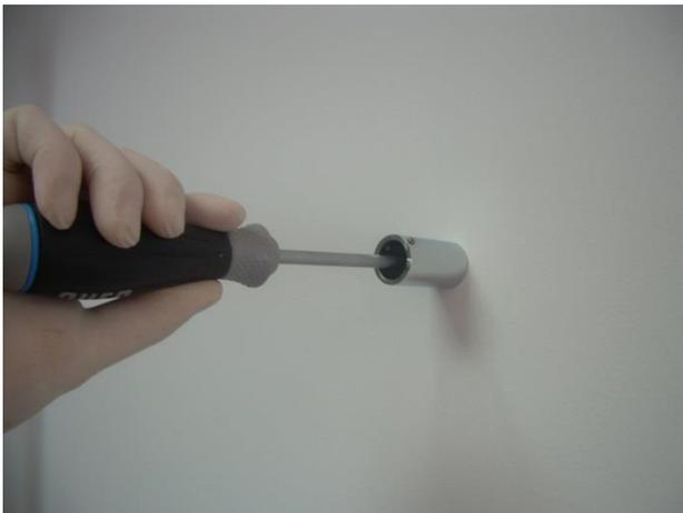
Inserire il tassello nel foro e fissare il supporto alla parete serrando la vite.
