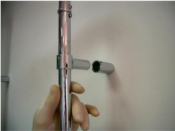
Inserire il perno nel supporto e la prolunga sul raccordo di uscita superiore.
