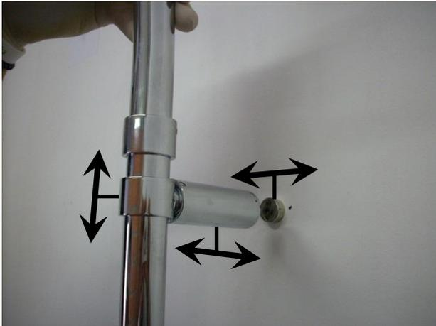
Positionieren Sie die Verlängerung in die richtige Lage mit einer Wasserwaage.
