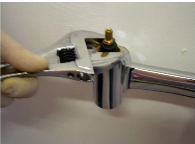
Inserire la cartuccia nel corpo del miscelatore e serrare la calotta con chiave esagonale da 27 mm.
