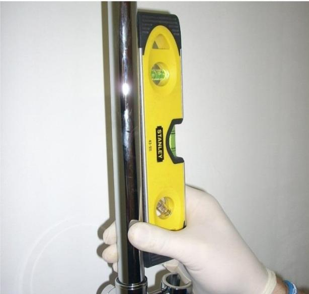
Con l'ausilio di una livella posizionare correttamente in bolla la colonna.
