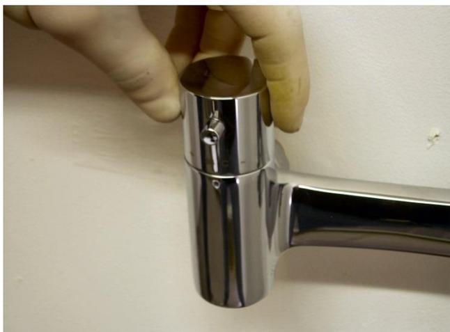
Inserire la manopola con il pulsante rivolto in avanti e con l'indicazione 38°C allineata alla tacca presente sul miscelatore SENZA ruotare l'asta della cartuccia. Serrare il grano con chiave a brugola da 2 mm e inserire la placchetta.
