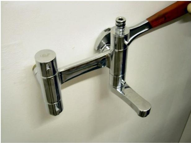
Montare il miscelatore termostatico alla parete serrando le calotte con chiave esagonale da 29 mm.
