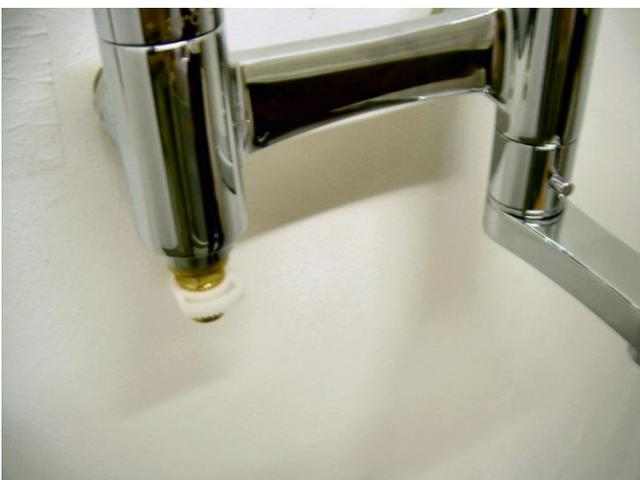
Inserire il raccordo come illustrato SENZA ruotare l'asta.
