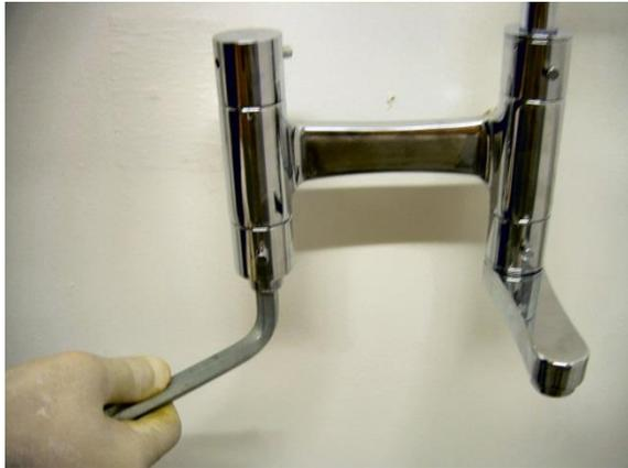
Avvitare il raccordo di uscita inferiore con chiave a brugola da 12 mm.
