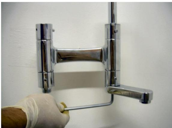
Avvitare l'erogatore della vasca con chiave a brugola da 6 mm.
