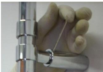
Serrare i grani di bloccaggio con chiave a brugola da 2 mm.
