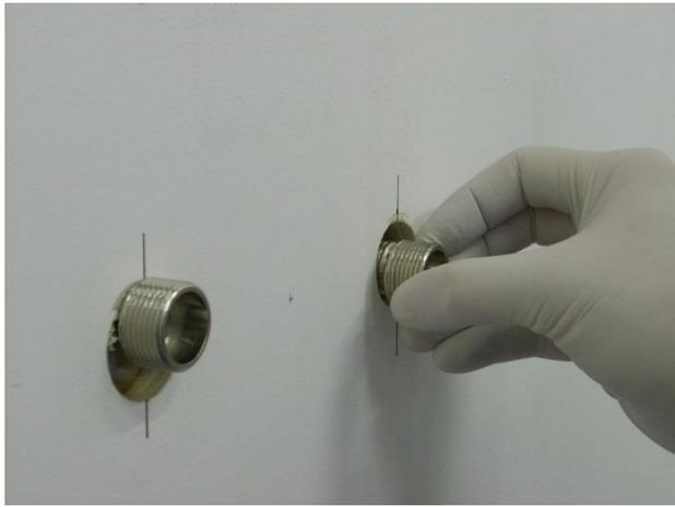
Avvitare i raccordi eccentrici agli attacchi dell'impianto, utilizzando canapa o similari per realizzare la tenuta idraulica.
