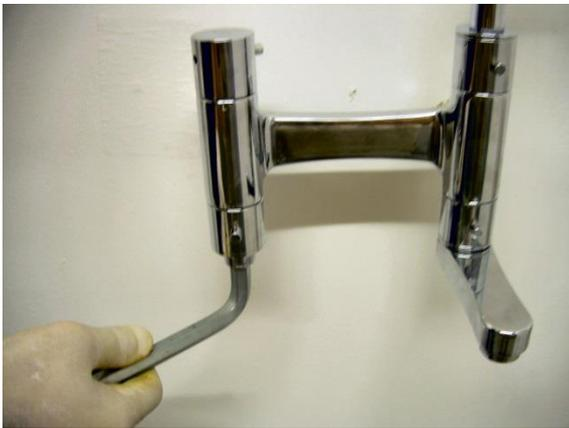
Svitare il raccordo di uscita inferiore con chiave a brugola da 12 mm.
