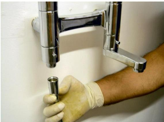
Avvitare il flessibile sul raccordo di uscita inferiore.
