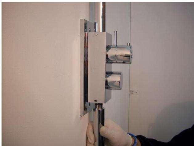
Inserire la parte inferiore della colonna nell'apposita sede.
