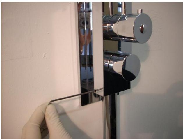
Svitare il grano di fissaggio della parte inferiore della colonna sul gruppo termostatico con chiave a brugola da 2 mm.
