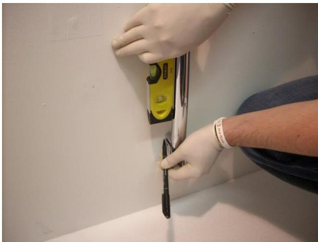
Con l'ausilio di una livella posizionare correttamente in bolla la parte inferiore della colonna e marcare la posizione del supporto di fermo.
