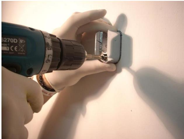
Inserire il tassello nel foro e fissare il supporto alla parete serrando la vite dopo averlo messo in bolla.
