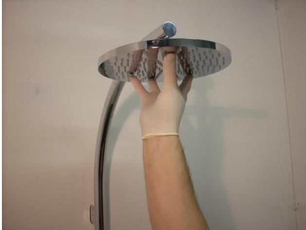
Avvitare il soffione all'attacco da 1/2" del tubo.
