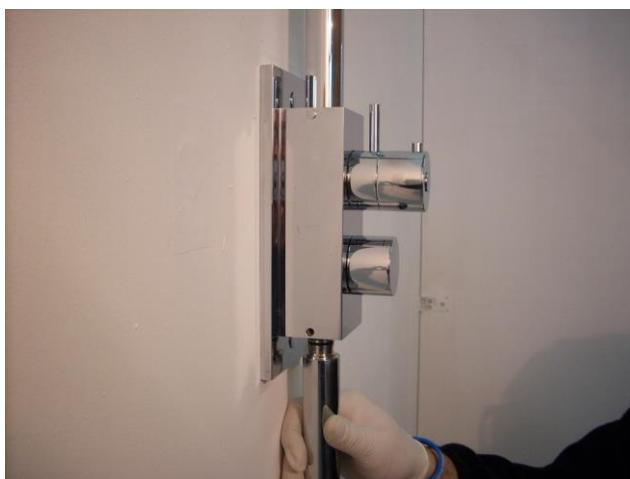
Inserire la parte inferiore della colonna nell'apposita sede.
