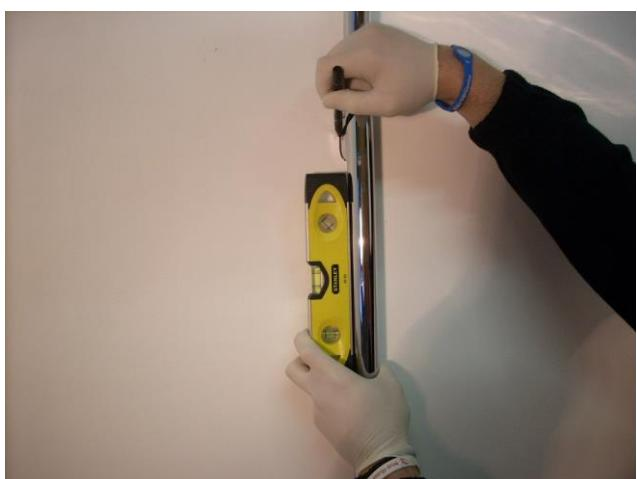
Con l'ausilio di una livella posizionare correttamente in bolla la parte superiore della colonna e marcare la posizione del supporto di fermo.
