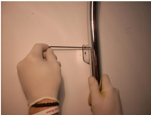
Smontare il supporto di fermo svitando i grani di fissaggio con chiave a brugola da 2 mm.
