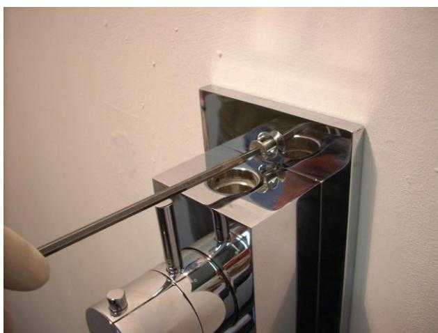
Fissare il gruppo termostatico alla parete serrando le viti con chiave a brugola da 4 mm.
