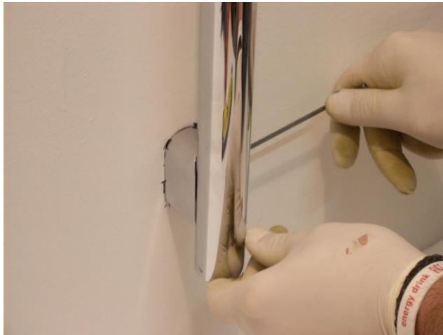
Infilare i perni della colonna inferiore nella traccia del supporto.
