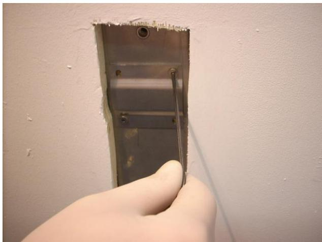
Rimuovere la piastrina di fissaggio svitando le 4 viti con chiave a brugola da 2.5 mm (in dotazione).
