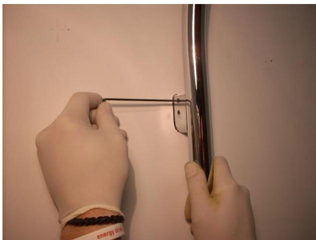
Infilare i perni della colonna superiore nella traccia del supporto. Assicurarsi che il tubo sia in battuta sul gruppo termostatico e serrare accuratamente i grani di fissaggio con chiave a brugola da 2,5 mm.
