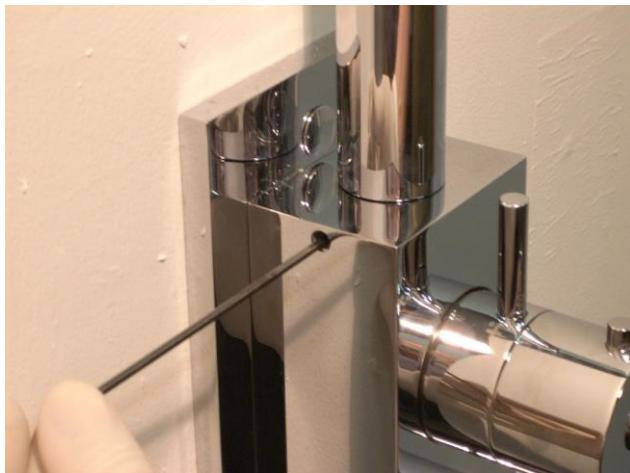
Fissare la parte superiore della colonna al gruppo termostatico serrando il grano di fissaggio con chiave a brugola da 2 mm.
