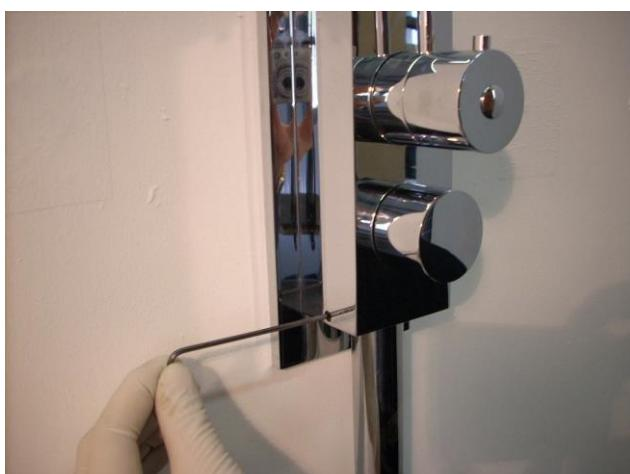
Fissare la parte inferiore della colonna al gruppo termostatico serrando il grano di fissaggio con chiave a brugola da 2 mm.
