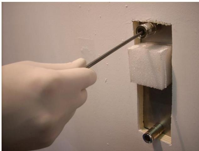
**Collaudare l'impianto - IMPORTANTE: pressione massima di prova 10 bar (statica).**
