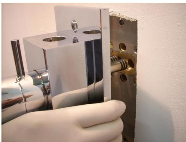
Montare il gruppo termostatico alla parte incasso inserendo le due spine negli appositi fori di adduzione dell'acqua e portando la piastra a contatto del rivestimento.
