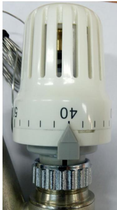
6.4. При промывке стояка рециркуляции необходимо выставить термоэлемент клапана в максимальное положение (дополнительная риска после 60 °C)
