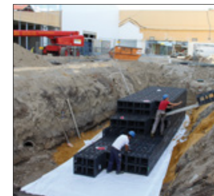
Capannone, Neu-Ulm (DE)
