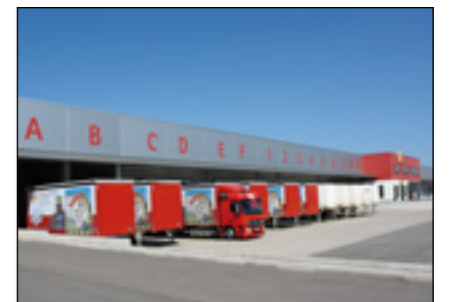
Centro logistico di Teningen
