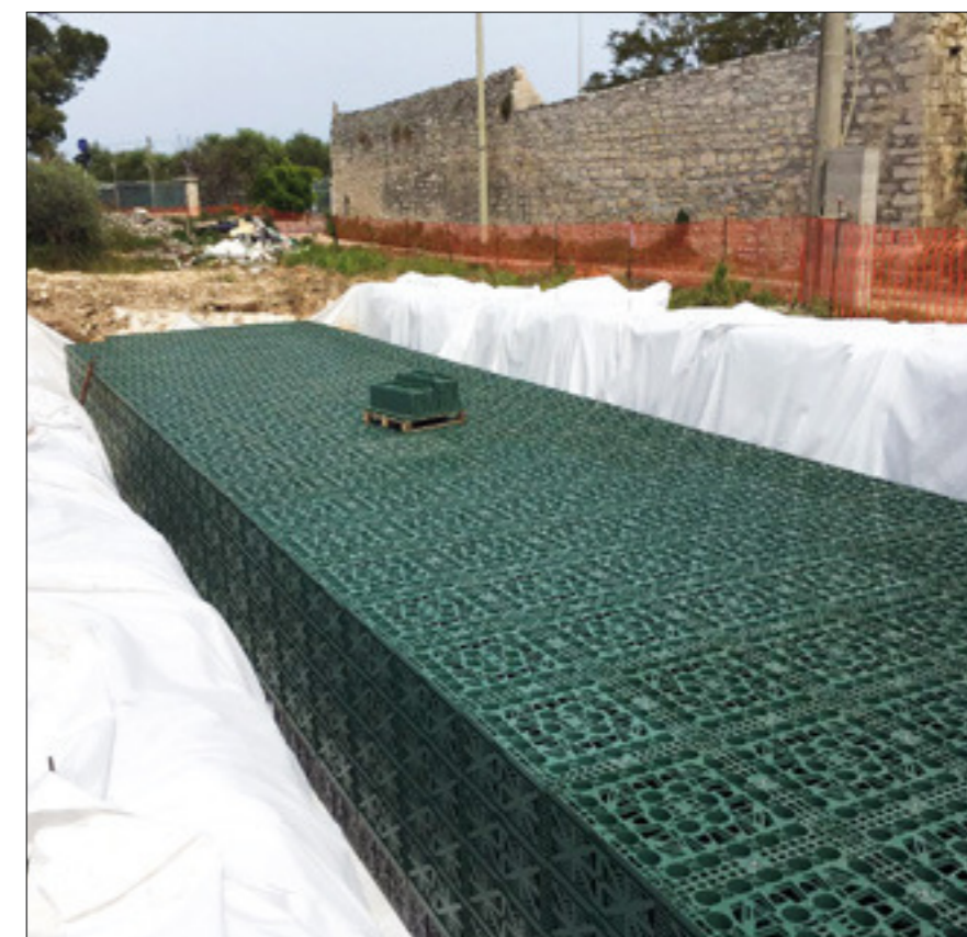
Raccordo autostradale SS16, Adriatica (IT)
