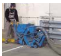
1 Pretrattamento del sottofondo, ad es. con pallinatura.
