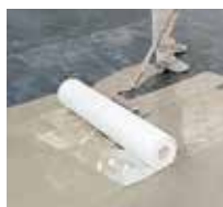
6 Il tessuto non tessuto speciale Triflex viene inserito su tutta la superficie evitando la formazione di bolle d'aria.
