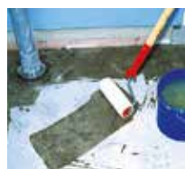
1 Applicare il primer sul collegamento alla parete e sulla superficie.
