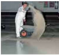
5 Il rivestimento fresco ad es. per i parcheggi può essere cosparso di sabbia.
