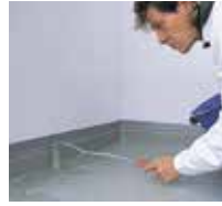
8 Applicare la sigillatura Triflex Cyl Finish 205 prima sui dettagli, ...
