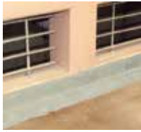
2 I collegamenti dei dettagli vengono impermeabilizzati con Triflex ProDetail.
