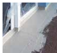
5 Viene applicato un secondo strato di Triflex ProDetail.
