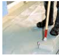
9 Viene applicato un secondo strato di Triflex ProTerra.
