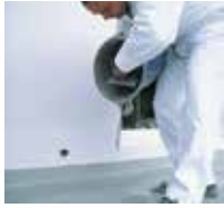
5 Applicare il rivestimento per superfici Triflex ProFloor ...
