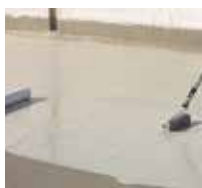
7 Un secondo strato di Triflex ProPark viene applicato fresco su fresco.
