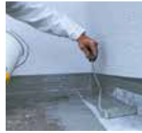
4 ... ricoprire abbondantemente con Triflex ProDetail.
