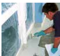
3 In primo luogo vengono impermeabilizzati i dettagli con Triflex ProDetail.
