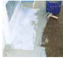
4 Il tessuto non tessuto speciale Triflex viene inserito su tutta la superficie evitando la formazione di bolle d'aria.
