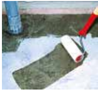
1 Applicare il primer sul collegamento alla parete e sulla superficie.
