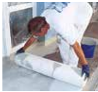
8 Il tessuto non tessuto speciale Triflex viene inserito su tutta la superficie evitando la formazione di bolle d'aria.
