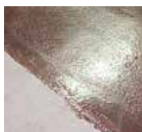
2 Applicare il primer sui collegamenti alla parete e sulla superficie.
