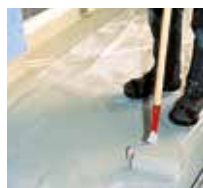
9 Viene applicato un secondo strato di Triflex ProTerra.
