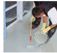
10 Lo strato di usura Triflex ProTerra viene applicato sulla superficie.
