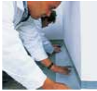
3 Applicare il tessuto non tessuto speciale Triflex evitando la formazione di bolle d'aria e ...
