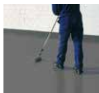
8 Viene applicata la sigillatura Triflex Ceryl Finish 209.
