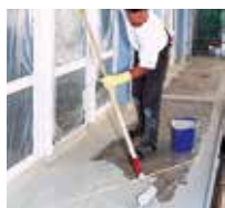
7 Sulla superficie viene applicato abbondante Triflex ProTerra.
