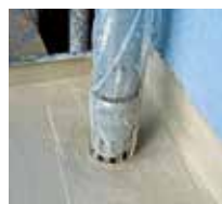
6 I dettagli sono impermeabilizzati in modo sicuro.
