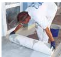
8 Il tessuto non tessuto speciale Triflex viene inserito su tutta la superficie evitando la formazione di bolle d'aria.
