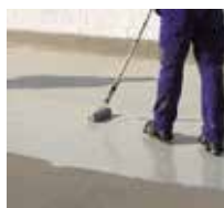
5 Sulla superficie viene applicato abbondante Triflex ProPark.
