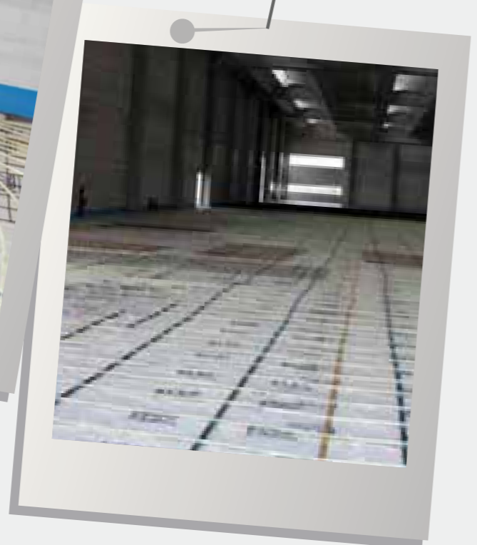
Capannone industriale, Varese Riscaldamento a pavimento sistema Modubarra
