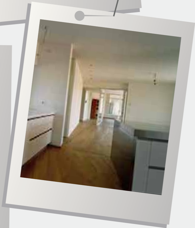
Abitazione, Venezia Riscaldamento e raffrescamento a pavimento sistema Cover 30
