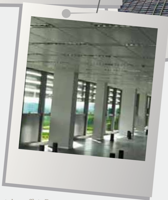
Capannone industriale e uffici, Prato Riscaldamento a pavimento sistema Industry System; Riscaldamento e raffrescamento a soffitto sistema b!klimax quadrotti 1200x600
