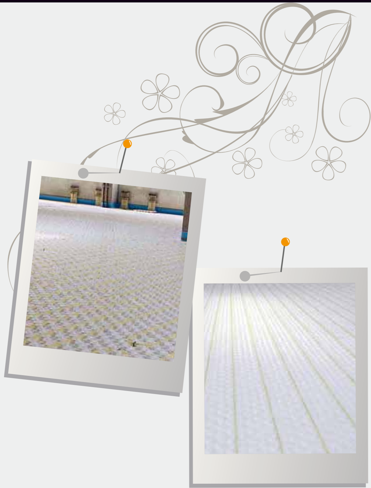
Ristrutturazione duomo, Udine Riscaldamento a pavimento sistema Sagomato Industriale
