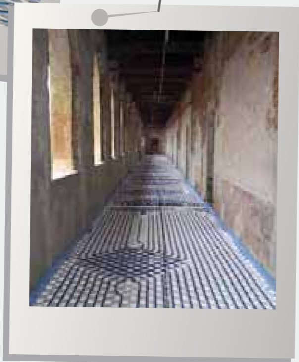
Ristrutturazione castello, Treviso Riscaldamento a pavimento sistema Sagomato Civile
