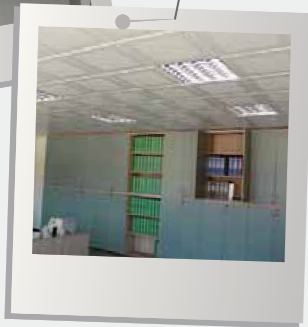
Uffici, Como Riscaldamento e raffrescamento a soffitto sistema b!klimax quadrotti 600x600
