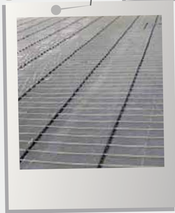
Capannone industriale e uffici, Treviso Riscaldamento a pavimento sistema Modulbarra; Riscaldamento e raffreddamento a soffitto sistema b!klimax quadrotti 600x600
