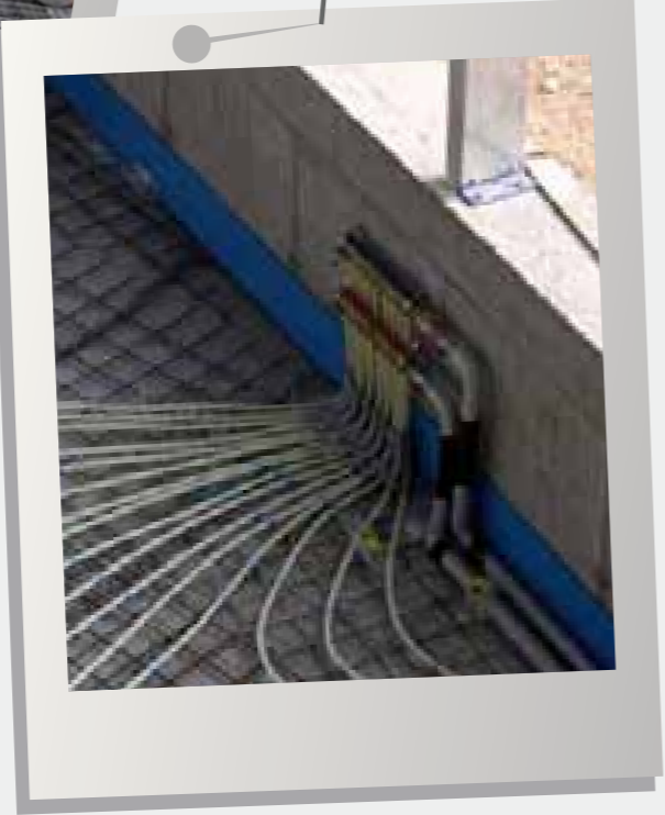
Capannone industriale, Trento Riscaldamento a pavimento sistema Modulbarra
