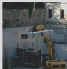
2. Movimentazioni del pilastro – Moving column
