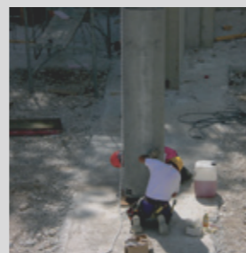
3. Fissaggio con controdadi – Tightening lock nuts
