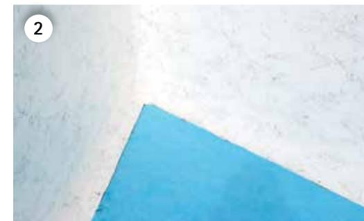
Tagliare il geotessile a seconda delle dimensioni della zona del pavimento facendo in modo che non venga apposto né sulla lamina né su altro geotessile.
