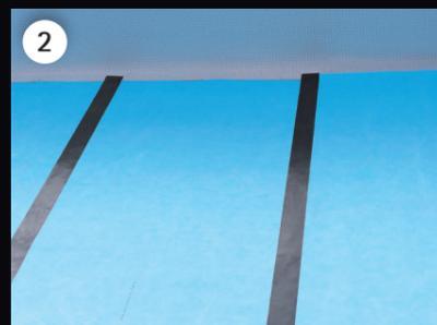
2 All'estremità opposta del geotessile, fissare il nastro per saldatura testa a testa per evitarne il movimento, senza che si accavalli sul geotessile.
