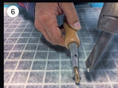
6 In questo tipo di saldatura non è necessario utilizzare pvc liquido, basta riscaldare un rullo in ottone per sigillare l'unione delle 2 membrane.
