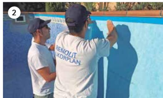
Installare il geotessile **RENOLIT ALKORPLAN** al di sotto del profilo di sostegno, esercitando pressione sulla zona incollata. Adattare il geotessile alla parete esercitando pressione con le mani per evitare che si formino rugosità.
