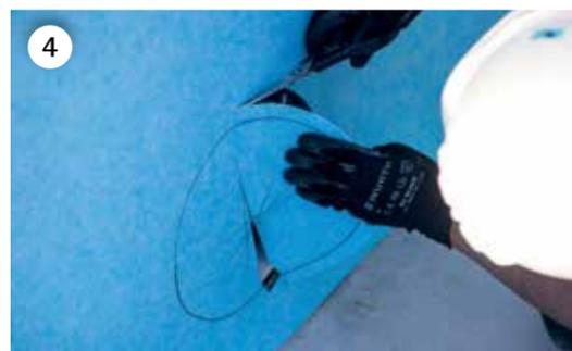
Dopo aver installato il geotessile, posizionarlo nella zona degli accessori della piscina e tagliare il pezzo di geotessile che li nasconde lungo suo perimetro esterno.
