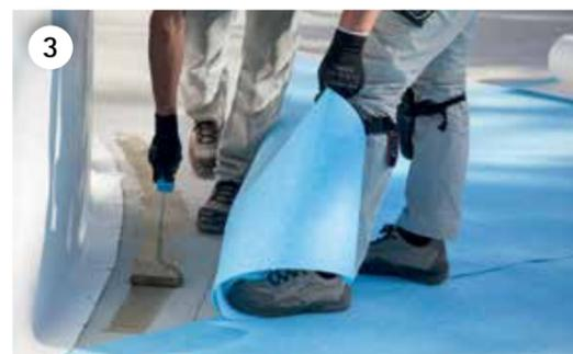
Fissarlo al pavimento applicando colla di contatto **RENOLIT ALKORGLUE** perché si tratta di un materiale molto leggero e il vento potrebbe sollevarlo o spostarlo. Far asciugare la colla di contatto sotto il geotessile prima di cominciare a installare la membrana.
