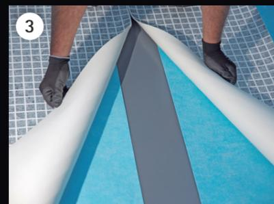
3 La saldatura delle membrane deve essere realizzata giusto al centro del nastro della saldatura testa a testa.
