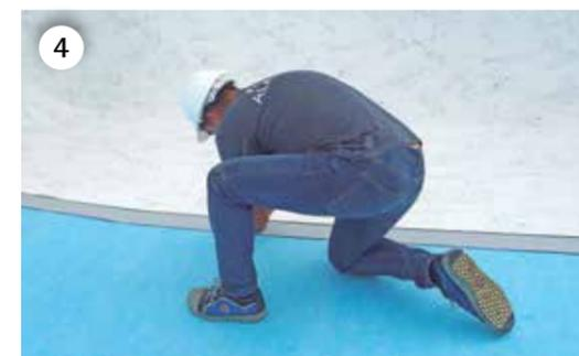
In caso di saldature testa a testa, dopo aver collocato il geotessile ritagliare ed eliminare il materiale nel punto in cui si sistemerà il nastro della saldatura di testa e dove si effettuerà la saldatura.
