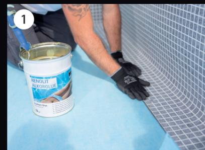
1 Collocare il geotessile da 150 cm senza montarlo sulla membrana. Fissarlo con l'adesivo per evitarne il movimento.
