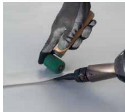
La saldatura deve essere realizzata con rullo di silicone, facendo in modo che tutta la superficie del rullo sia sempre a contatto con la membrana.
