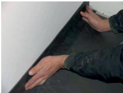
5 - Premere accuratamente la fascia Latomuro contro le pareti.
