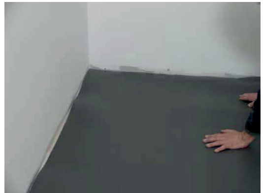
2 - Stendere accuratamente il materassino accostandolo alle pareti.
