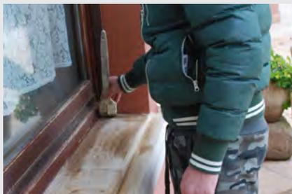
Preparare il materiale che serve per incollare. (Colla bicomponente da rivestimento con lattice al 40%)
