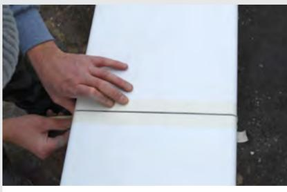
sigillare le fughe con il Coprifuga da esterno tra una barra e l'altra, silicone fornito da Coprimuro.net.
