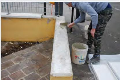
posizionare il coprimuro e procedere con l'incollatura, verificare battendo sulla sua superficie se il "suono" ci conferma la piena aderenza della colla, posizionare le barre evitando imperfezioni tra una barra e l'altra aiutandosi con strumenti tipo filo e livelle facendo attenzione a non graffiare la superficie.
