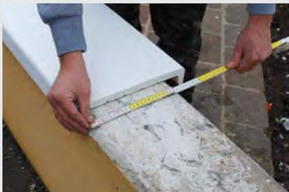
Assicurarsi che il coprimumo sia della misura compatibile, la misura va rilevata 1 cm sotto la superficie interna di appoggio.
