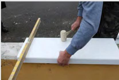
Importantissimo lasciare una fuga di 3mm per i prodotti chiari e di almeno 5mm per quelli scuri. La maggiore attenzione va data alle fughe che devono essere completamente pulite da residui di colle. Tra le fughe posizionare il coprigiunto fornito da Coprimuro.net in polietilene reticolato a celle chiuse.
