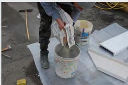
**DOPPIA SPALMATURA** spalmare la colla su tutta la superficie interna del coprimuro e del supporto, avendo la massima attenzione di fermarsi 2 cm prima della fine e l'inizio barra, non riempire la fuga tra una barra e l'altra e lo spazio tra lo sgocciolatoio e il muro. con la colla.
