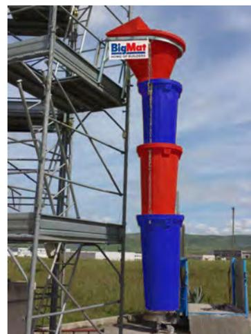
Sistema scarica detriti modulare realizzato con componenti in Polietilene stampati mediante la tecnologia dello stampaggio rotazionale uniti con catene in acciaio.
