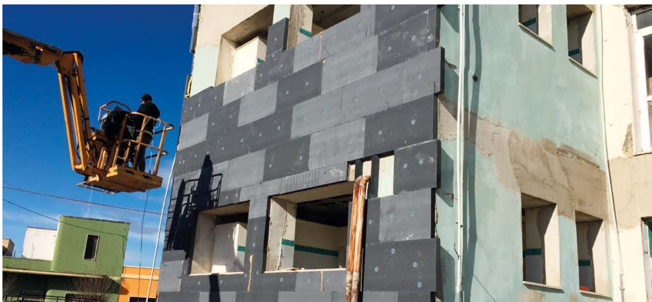
Fig. 05 - Isolamento a cappotto, Scuola di salice salentino
