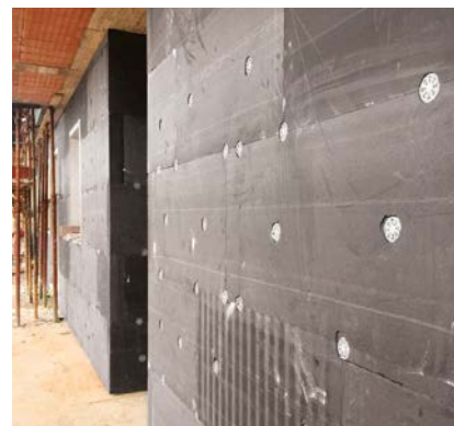
Fig. 04 - Isolamento a cappotto
