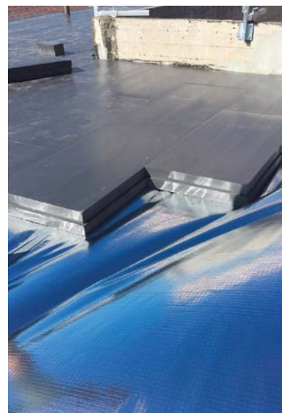
Isolamento copertura scuola Taurisano
