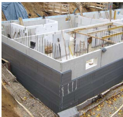
Fig. 03 - Isolamento di pareti controterra
