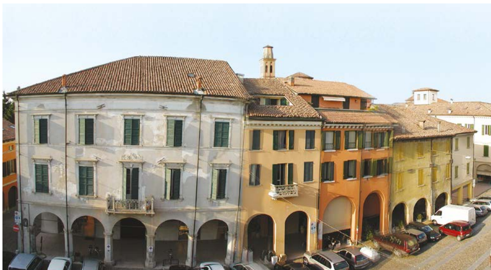
Ristrutturazione di tetti a falde
