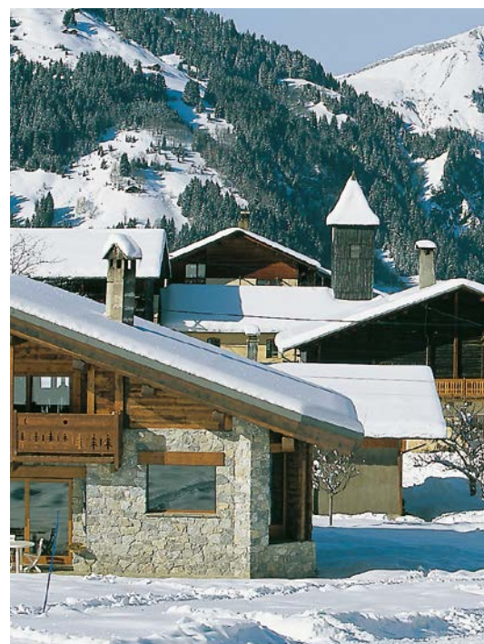
Tetti a falde isolati termicamente
