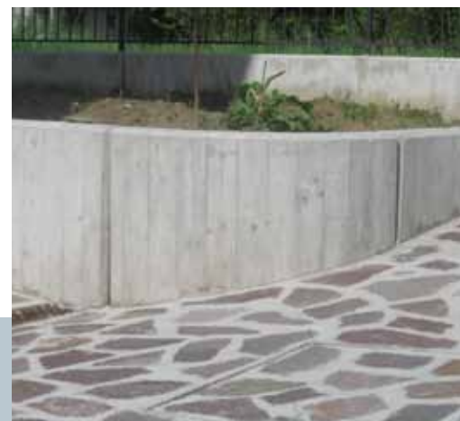
Cantiere Ravenna Impresa Aurora Immobiliare
