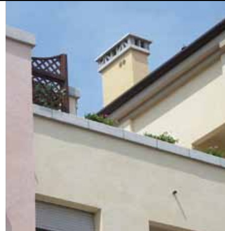
Cantiere Granarolo Emilia (BO) Impresa Coop Costruzioni (BO)
