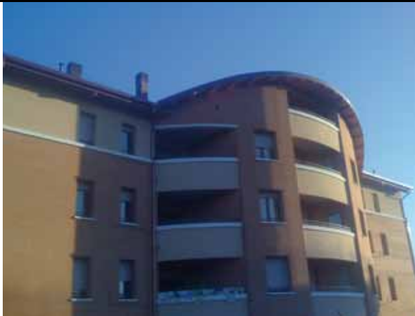
Cantiere Bazzano (BO) Impresa Asfalti Costruzioni
