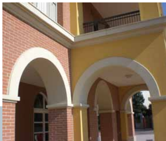
Cantiere Bologna Impresa CESI
