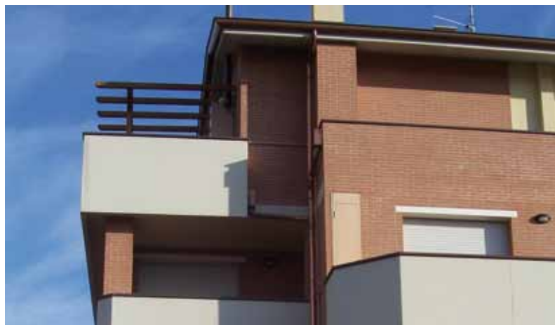
Cantiere Ozzano dell'Emilia (BO) Impresa CESI
