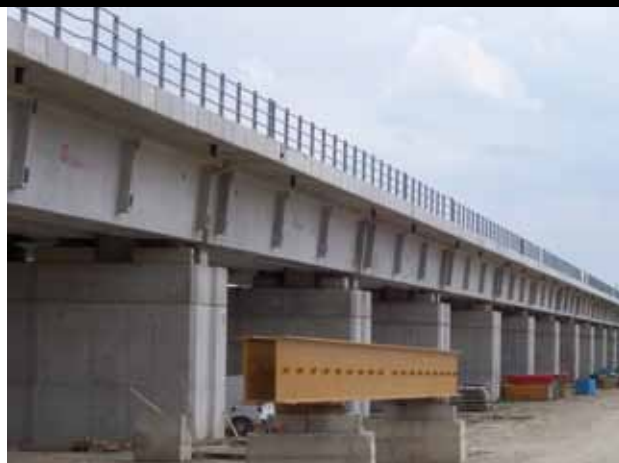
Cantiere Alta velocità (MO) Impresa Coop Costruzioni (MO)
