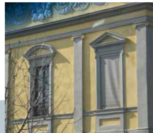
Cantiere Verona Impresa Sensi
