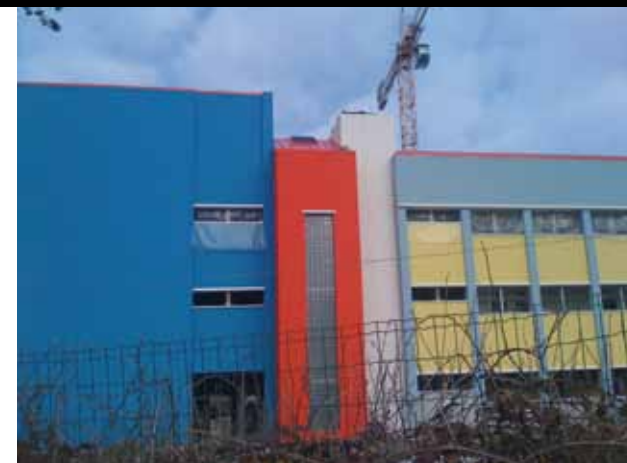
Cantiere Baggiovara (MO) Impresa CMB
