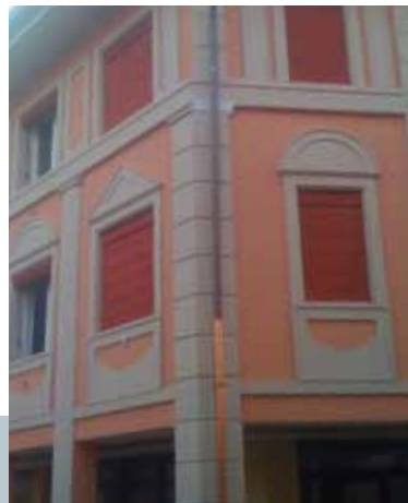
Cantiere Cento (FE) Impresa F. Martinelli
