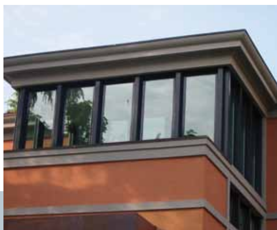
Cantiere Via Murri (BO) Impresa Gemar Tre
