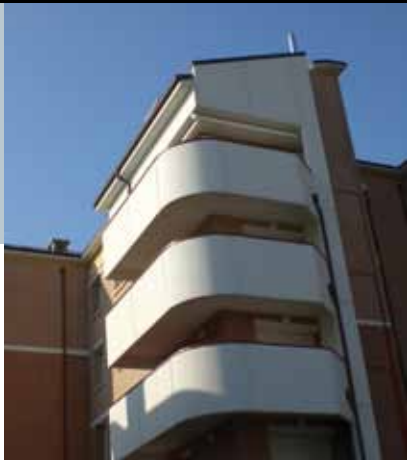
Cantiere Granarolo Emilia (BO) Impresa ITER
