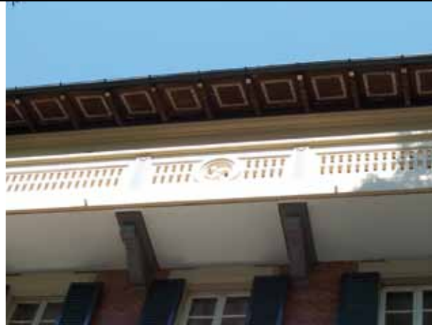
Cantiere Via Zanolini (BO) Impresa Proebios
