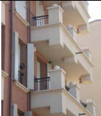
Cantiere Bologna Impresa Zagnoni
