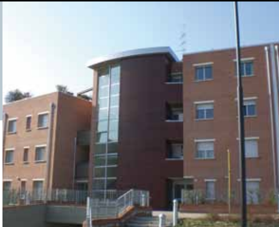
Cantiere LEXUS Castel Maggiore (BO) Impresa CESI
