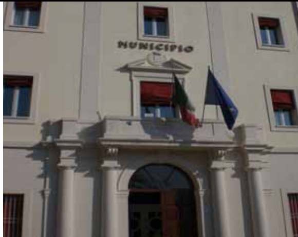
Cantiere Castel Maggiore (BO) Impresa General Costruzioni
