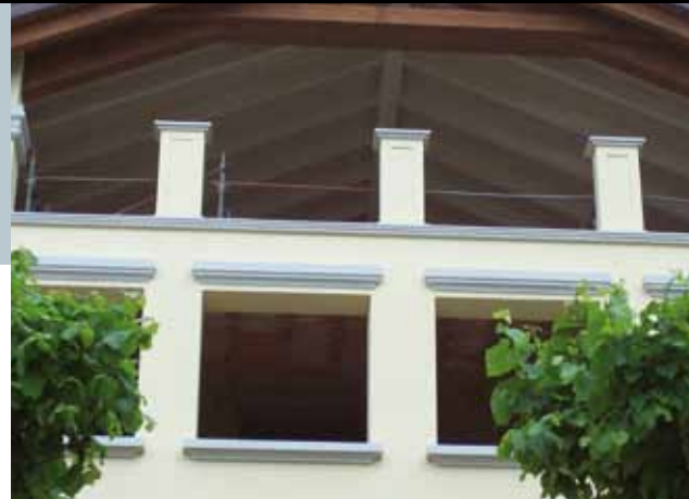
Cantiere Lizzano in Belvedere (BO) Impresa Lo Baido
