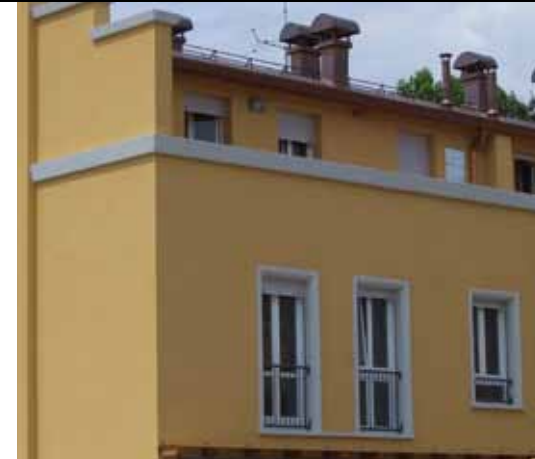
Cantiere S.Giovanni in Persiceto (BO) Impresa F. Martinelli
