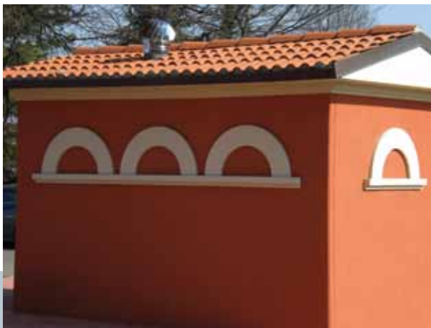
Cantiere Bologna Impresa CESI
