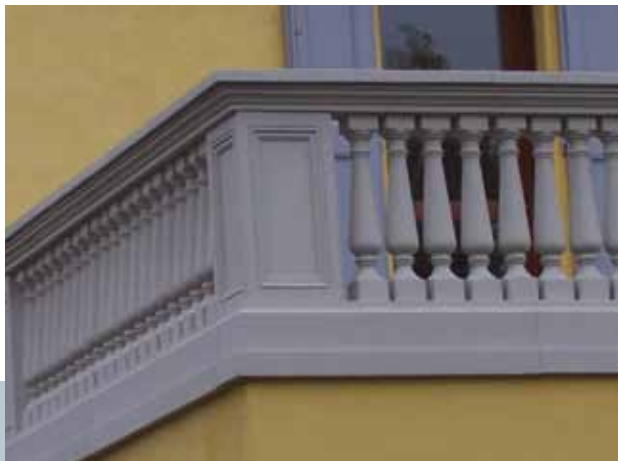
Cantiere Castenaso (BO) Impresa Ediltecnica Cantieri
