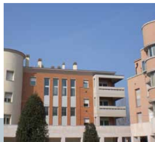
Cantiere Pianoro (BO) Impresa P.E.S.I.C
