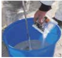
2 Vor der Verarbeitung wird Triflex Katalysator in das Harz eingerührt.
