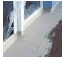
5 Eine zweite Schicht Triflex ProDetail wird aufgebracht.
