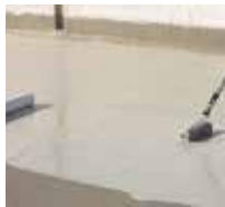
7 Eine zweite Schicht Triflex ProPark wird frisch in frisch aufgebracht.
