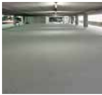
6 Abschließend wird die Fläche mit Triflex Cryl Finish 209 versiegelt.
