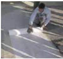
5 Das Triflex Spezialvlies wird vollflächig und blasenfrei eingearbeitet.
