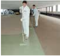
4 Die Beschichtung Triflex Cryl Finish 209 gleichmäßig auftragen.
