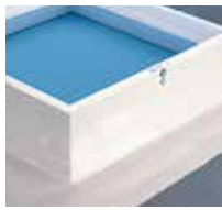
7 Bereits nach 30 Minuten ist die Abdichtung regenfest.
