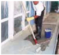
7 Auf die Fläche wird Triflex ProTerra satt vorgelegt.
