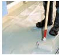
9 Eine zweite Schicht Triflex ProTerra wird aufgebracht.
