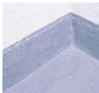
11 Der Balkon ist innerhalb eines Tages fertig.
