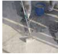
4 Auf die Fläche wird Triflex ProTect satt vorgelegt.
