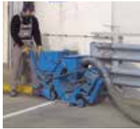
1 Untergrundvorbehandlung, z. B. durch Kugelstrahlen.
