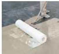
6 Das Triflex Spezialvlies wird vollflächig und blasenfrei eingearbeitet.
