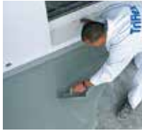
6 ... mit einer Kelle aufziehen und ...
