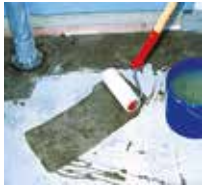
1 Wandanschluss und Fläche grundieren.
