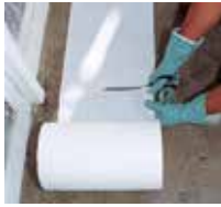
2 Triflex Spezialvlies-zuschnitte vorbereiten.
