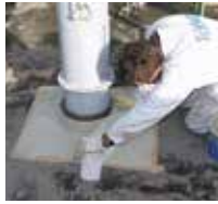
3 Zuerst werden alle Details mit Triflex ProDetail abgedichtet.
