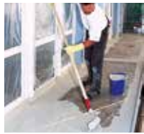
7 Auf die Fläche wird Triflex ProTerra satt vorgelegt.
