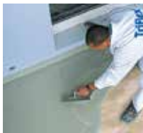
11 ... mit einer Kelle aufziehen und egalisieren.
