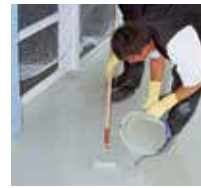
10 Die Nutzschrift Triflex ProTerra wird auf der Fläche aufgebracht.
