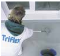
9 ... dann auf die Fläche aufbringen und ...
