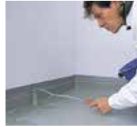
8 Die Versiegelung Triflex Cyl Finish 205 erst an den Details, ...
