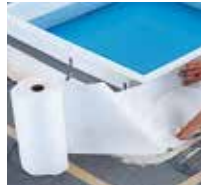
4 Triflex Spezialvlies in das vorgelegte Material blasenfrei einarbeiten.
