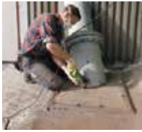
1 Der Untergrund wird vorbereitet.
