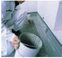
2 Anschlüsse mit Triflex ProDetail vorlegen.
