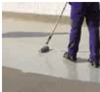
5 Auf der Fläche wird Triflex ProPark satt vorgelegt.
