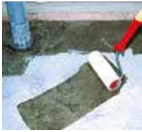
1 Wandanschluss und Fläche grundieren.
