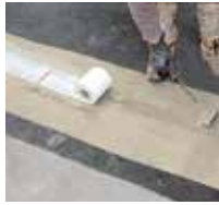
3 ... Fugen werden mit Triflex ProDetail abgedichtet.
