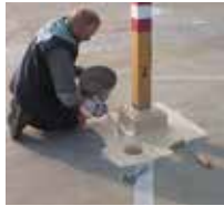
3 Zuerst werden alle Details mit Triflex ProDetail abgedichtet und ...
