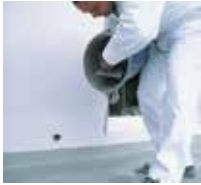
5 Die Flächenbeschichtung Triflex ProFloor ...
