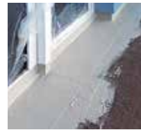
5 Eine zweite Schicht Triflex ProDetail wird aufgebracht.
