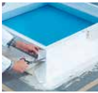
5 Vlies an den Ecken einschneiden und Triflex ProDetail noch einmal satt nachlegen.
