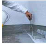
4 ... mit Triflex ProDetail satt nachlegen.
