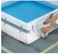
1 Übergang zwischen Lichtkuppel- und Sanierungskranz mit Klebeband abkleben.
