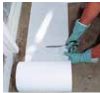
2 Triflex Spezialvlies-zuschnitte vorbereiten.
