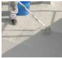
7 Bei Bedarf kann nach ca. 1 Std. die Fläche versiegelt werden.
