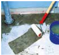
1 Wandanschluss und Fläche grundieren.
