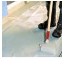
9 Eine zweite Schicht Triflex ProTerra wird aufgebracht.
