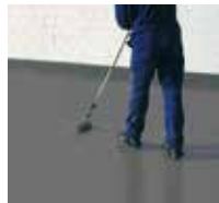
8 Die Versiegelung mit Triflex Ceryl Finish 209 wird auftragen.
