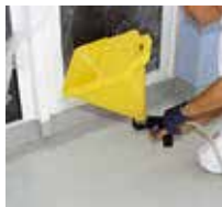
13 ... Triflex Micro Chips einblasen.
