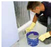
12 Die Versiegelung Triflex Cryl Finish 205 auftragen und ...
