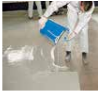
3 Der Verlaufmörtel Triflex DeckFloor wird aufgetragen ...
