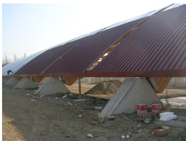
Copertura Curva realizzata con pannello Mono/Top e Lamiera Grecate - Lombardia
