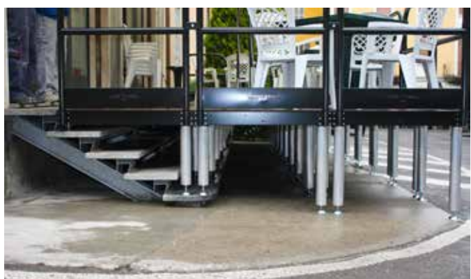
Pedana plateatico / dehors montato su scalinata per ampliamento bar. La pedana è stata messa a livello con piantoni di diverse misure. La lunghezza dei piantoni è stata ricavata direttamente al montaggio
