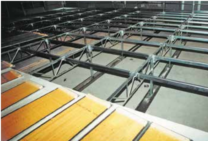
Palco in fase di montaggio
