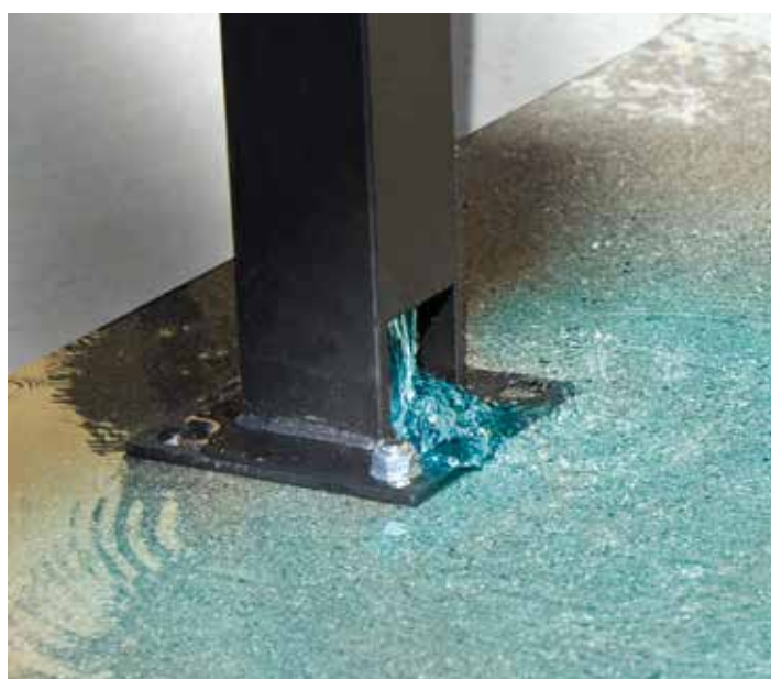
L'acqua piovana defluisce nei canali perimetrali e viene scaricata nelle colonne di sostegno.
