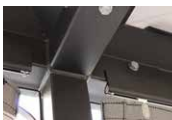
Binario in alluminio fissato all'interno della struttura per l'inserimento di tendaggi scorrevoli
