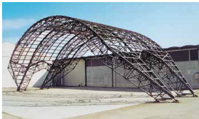
Collaudo eseguito in officina prima della zincatura a caldo
