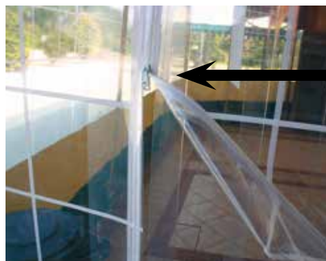
Telo laterale in crystal trasparente con apertura / chiusura centrale a cerniera
