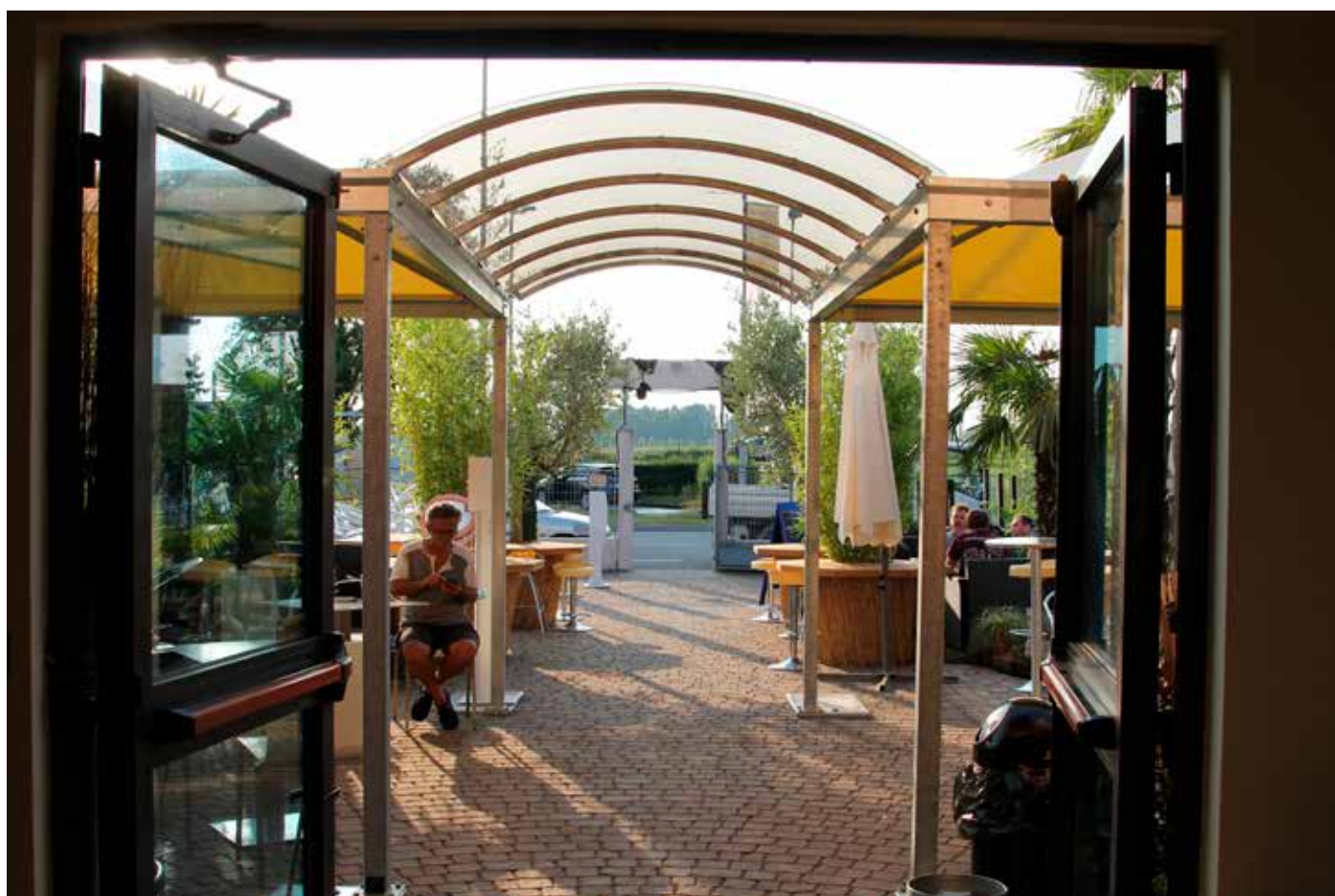
Tunnel installato tra gazebo con copertura in policarbonato per entrata ristorante. Sistema di raccolta acqua nei canali di gronda dei gazebo.
