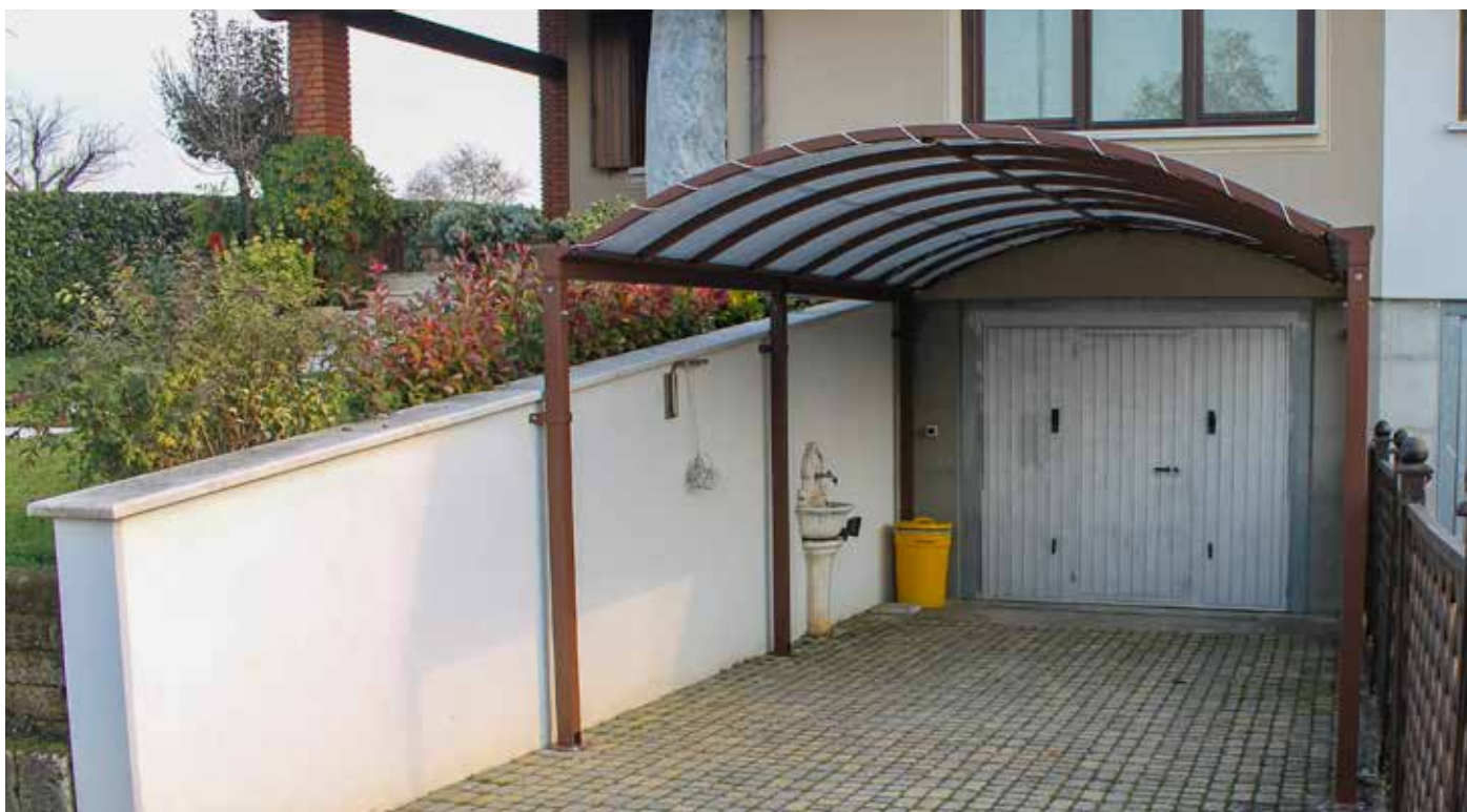
Gazebo Primavera 3,5 x 6 m con tetto a tunnel senza timpani e copertura in rete ombreggiante 90% mod. piattina colore grigio installato su rampa di accesso. Trattamento superficiale di zincatura a caldo e verniciatura colore ruggine.
