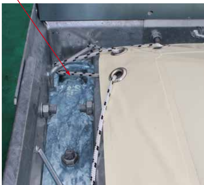
L'acqua piovana defluisce nei canali perimetrali e viene scaricata nelle colonne di sostegno.
