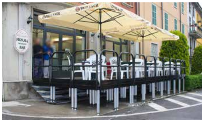
Pedana plateatico / dehors montato su scalinata per ampliamento bar. La pedana è stata messa a livello con piantoni di diverse misure. La lunghezza dei piantoni è stata ricavata direttamente al montaggio
