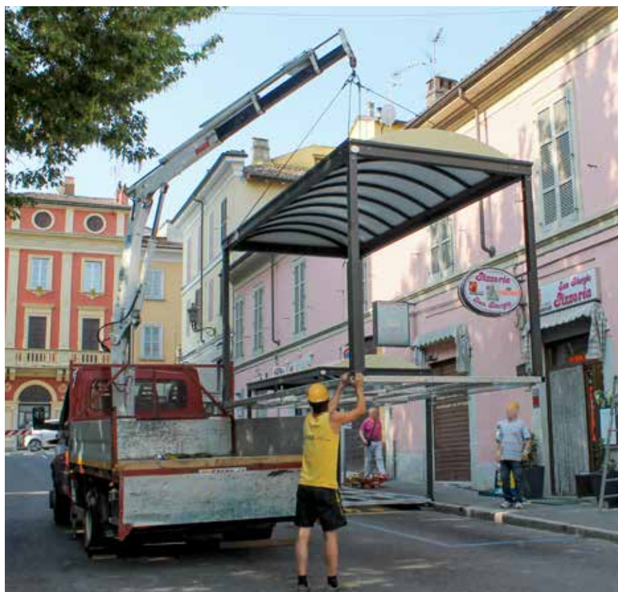
Fase d'installazione: camion con gru
