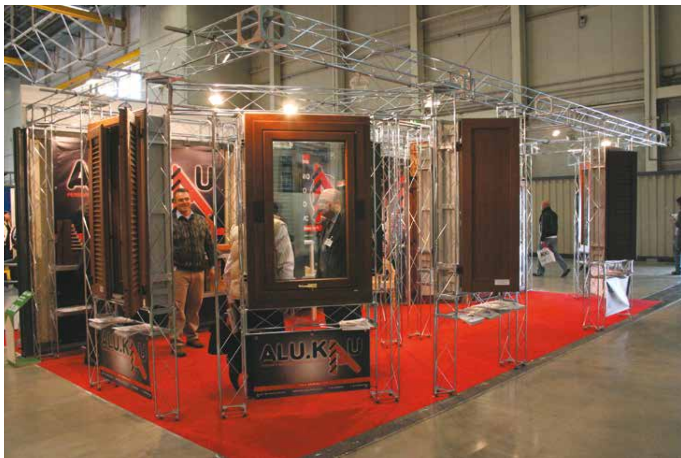
Stand fieristico realizzato con tralicci quadrati lato 20 cm
