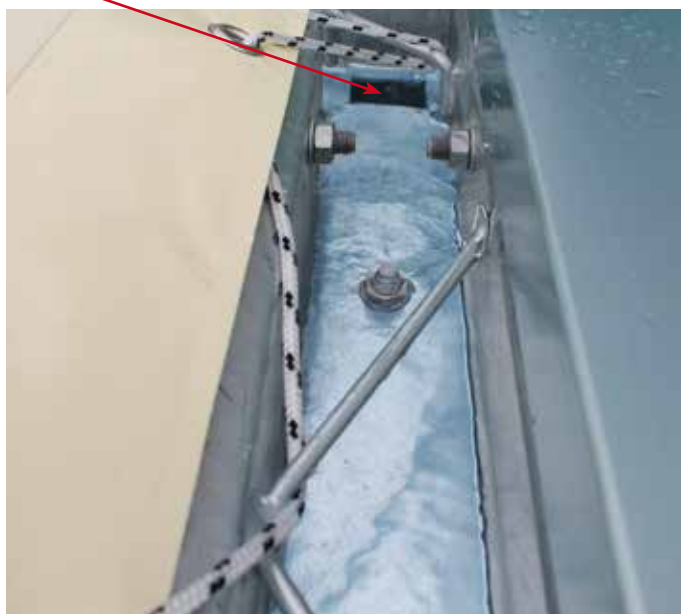
Fissaggio telo di copertura al canale di gronda
