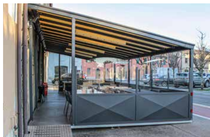
Fase di installazione
