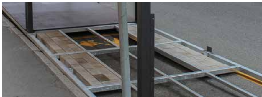
Zavorramento con mattoncini alloggiati all'interno della pedana
