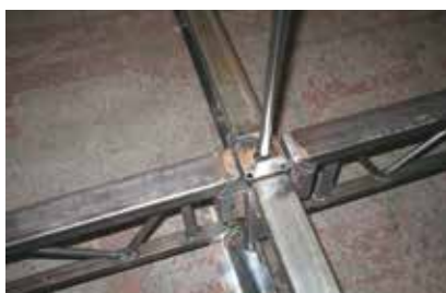
Regolazione dall'alto con chiave a brugola
