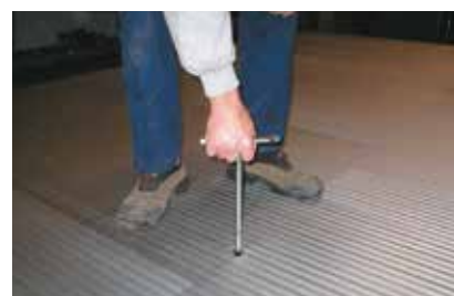
Regolazione dall'alto a piano di calpestio montato
