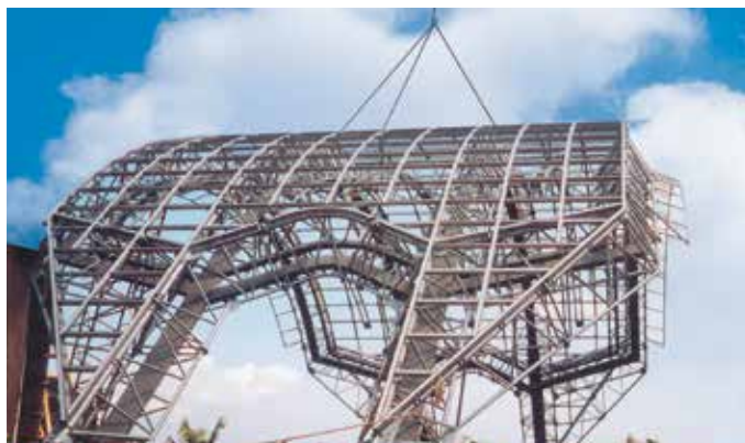
Fase di montaggio presso il villaggio turistico - Matanzas
