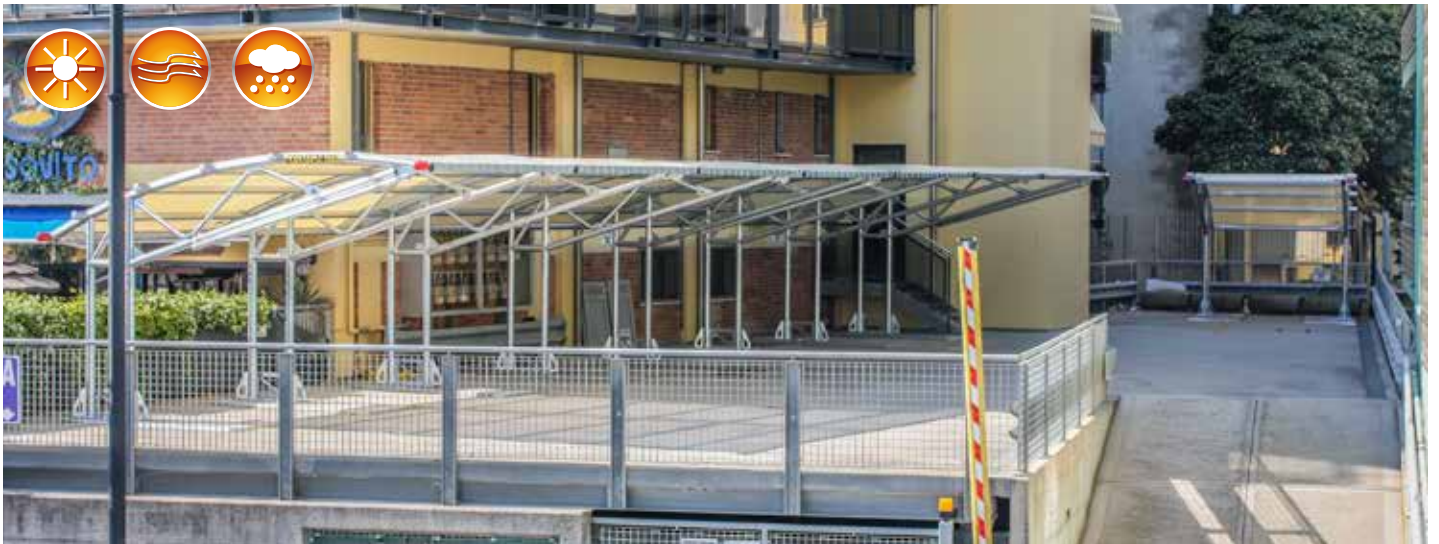
Pergolato composto da sette moduli più uno singolo, montato su piastroni in acciaio in semplice appoggio, copertura rete in PVC
