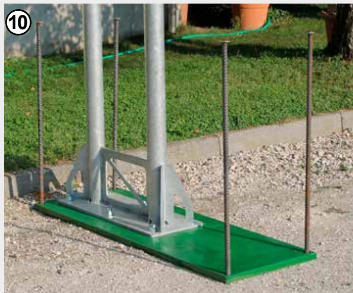
Piastrone ridotto con fissaggio aggiuntivo tramite puntazze conficcate nel terreno
