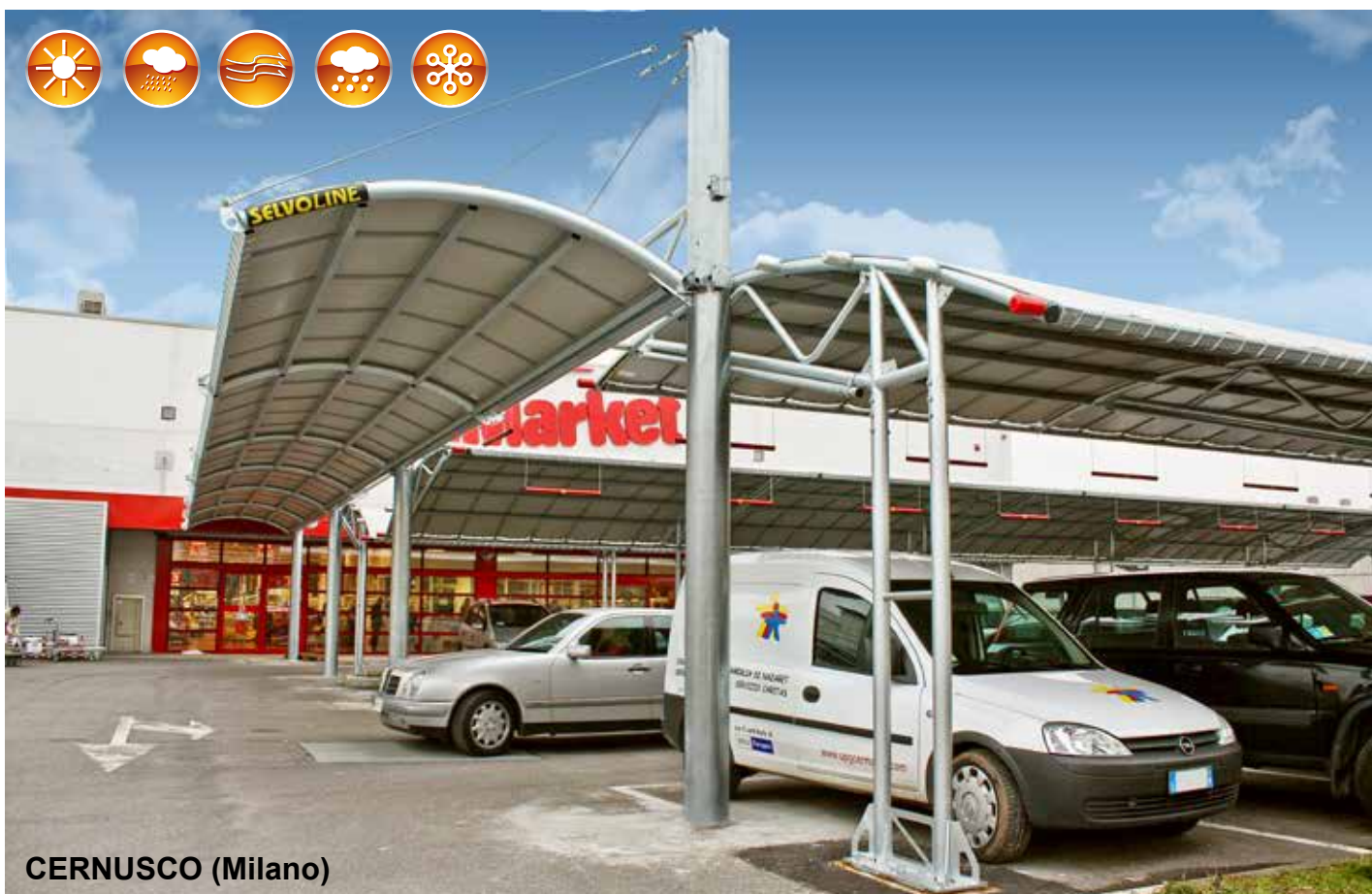
Copertura: telo in PVC - colore grigio Versione con piloni allungati di 80 cm, fissaggio al suolo su plinti
