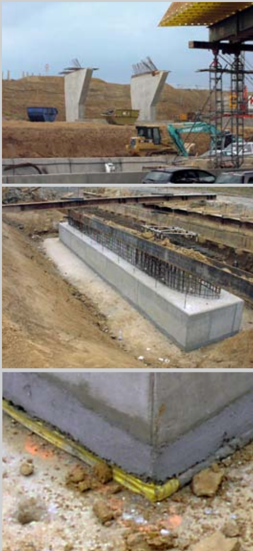
pilastri di un ponte di un cavalcavia autostradale
