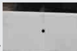
intorno al foro posizionare delle strisce di nastro adesivo di carta questo aiuterà a rimuovere l'eccesso di ancorante chimico
