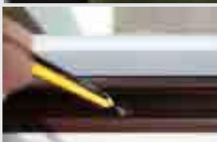
segnare con una matita il punto dove forare con una punta da trapano da Ø 6
