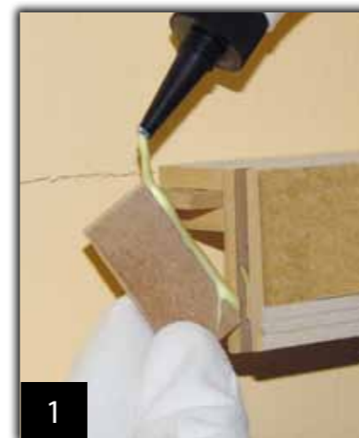
1 Giunto lineare con inserti in MDF
