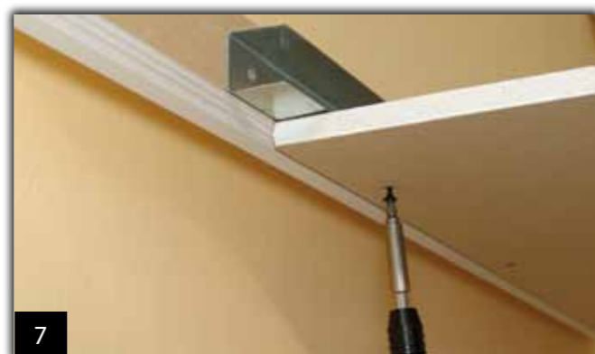
7 Fissare il pannello in cartongesso
