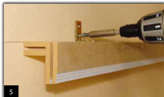
5 Fissare il profilo, inserendo la vite nel tassello
