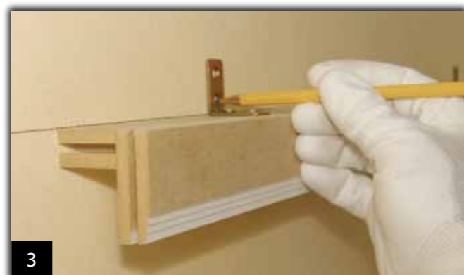
3 Segnare nel foro inferiore dello squadretto
