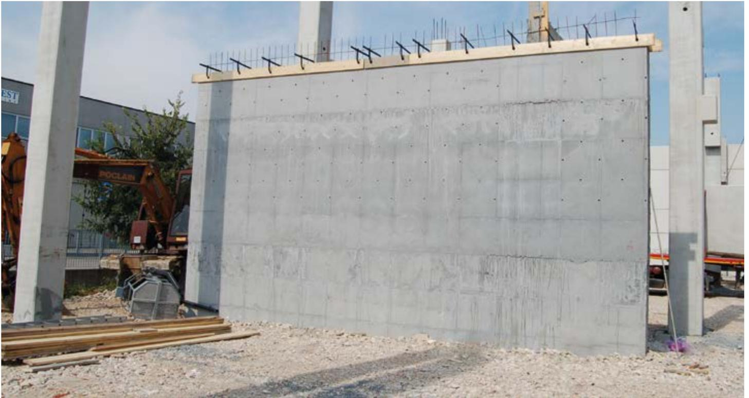
GEOPANEL è un sistema facile ed intuitivo di casseforme modulari in ABS per la realizzazione di murature, fondazioni e pilastri in calcestruzzo.
