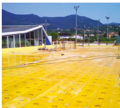
① PREPARAZIONE IMPALCATO DI BASE
