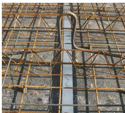
④ POSA ARMATURA
