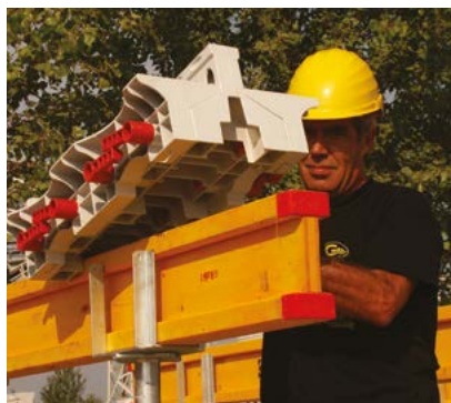
① POSA TRAVETTI Y + CUNEO
