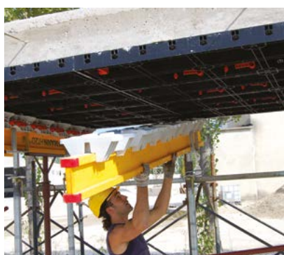
⑥ RIMOZIONE TRAVETTO H
