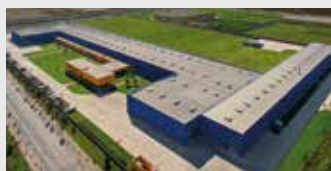
Hörmann Tianjin, Cina
