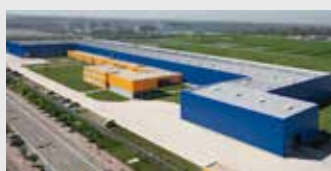
Hörmann Tianjin, Cina
